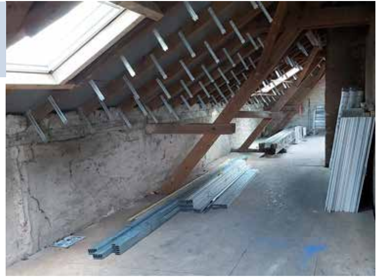
MISE EN PLACE DES VELUX 10 139 €
